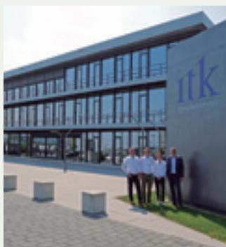
ITK Engineering GmbH. Inovativna poslovna zgrada koja se nalazi u Njemačkoj. ECOi - PACi
